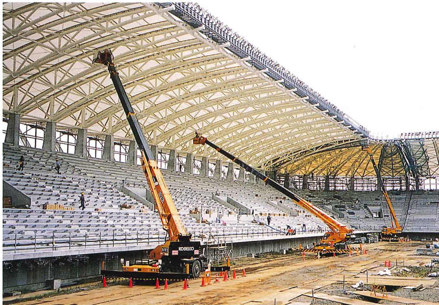
スタジアム 塗装作業 (45tラフター・25tラフター)
