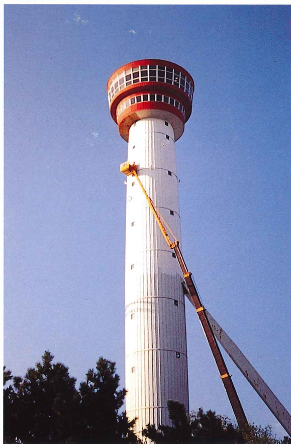
展望タワー 塗装作業 (45tラフター)
