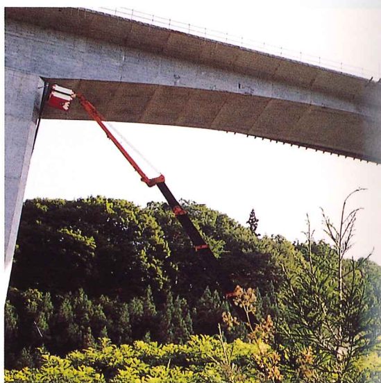
高速道 雨樋取付工事 (45tラフター)
