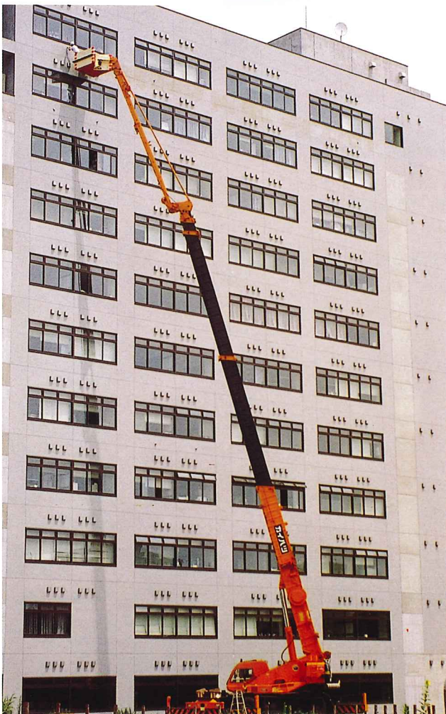
壁面点検作業 (45tラフター)
