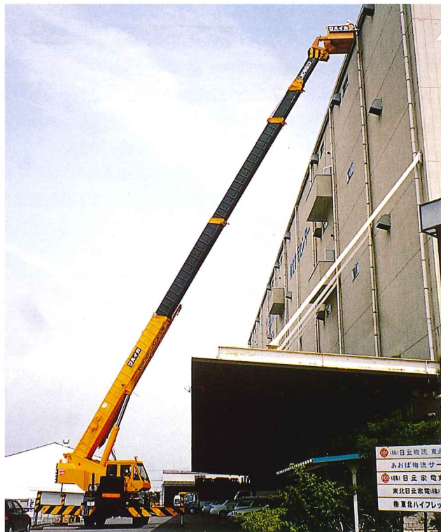
倉庫 補修工事 (45tラフター)
